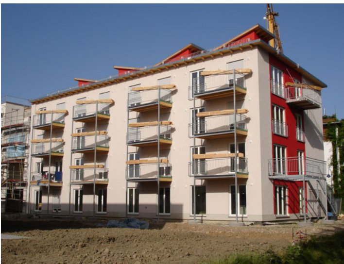
Das Bauprojekt „Vogelnest“ in Freiburg, ein viergeschossiger Holzbau nach dem Sentinel-Haus®-Konzept, wurde nun bezogen.
