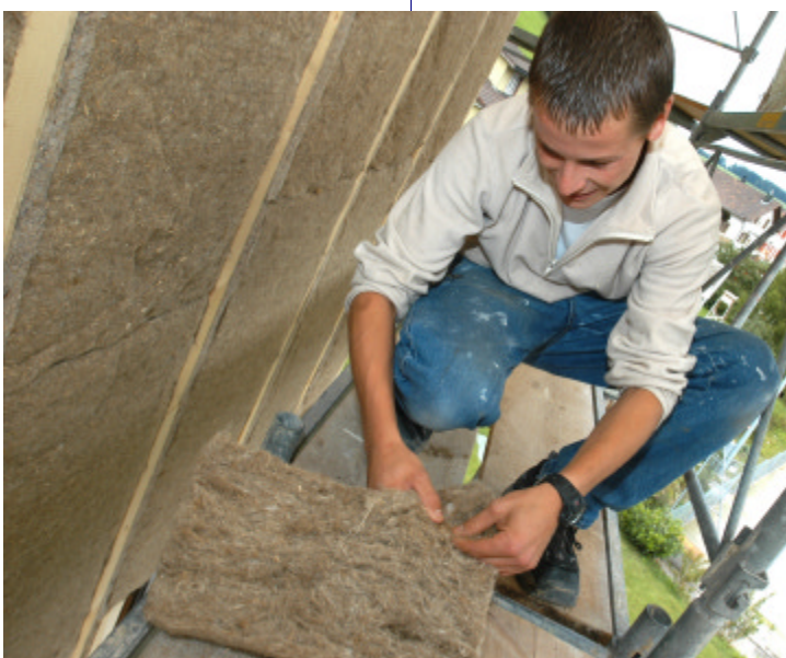
Naturdämmstoffe sind angenehm zu verarbeiten. Foto: Isover
